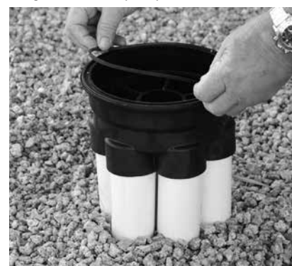
3. Nettoyer et installer le joint
