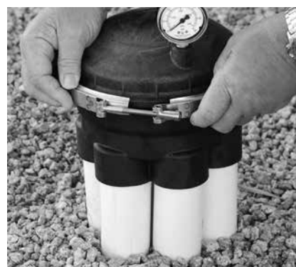
7. Placez le dome sur le module Sécurisez le dome et la base avec un serre clampes
