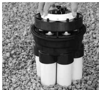
4. Insérez le module dans la base
