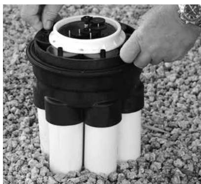
5. Tournez le module légèrement jusqu'à ce qu'il soit en place; aligné avec les goupilles
